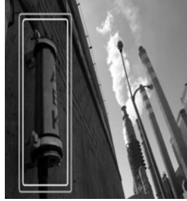
Çayırhan Termik Santrali
