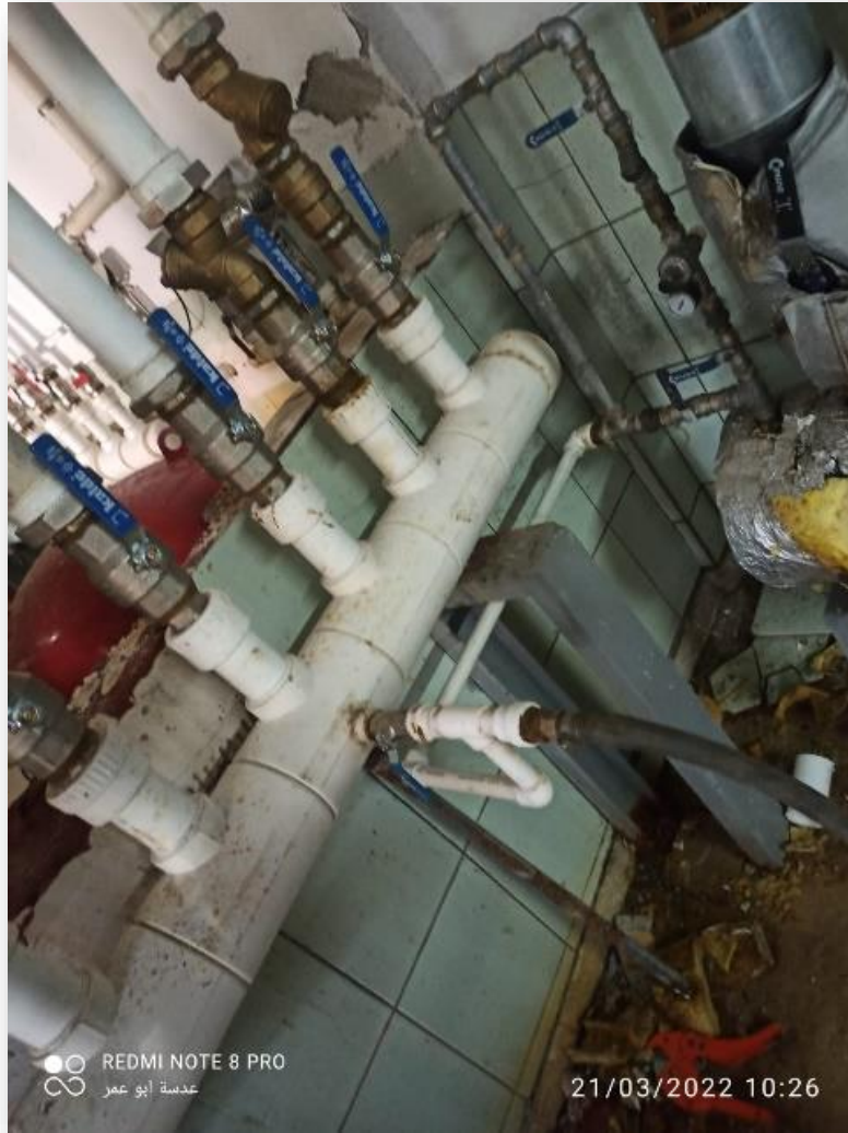
Görsel: Kampüs Altyapısı Proje Uygulamaları
