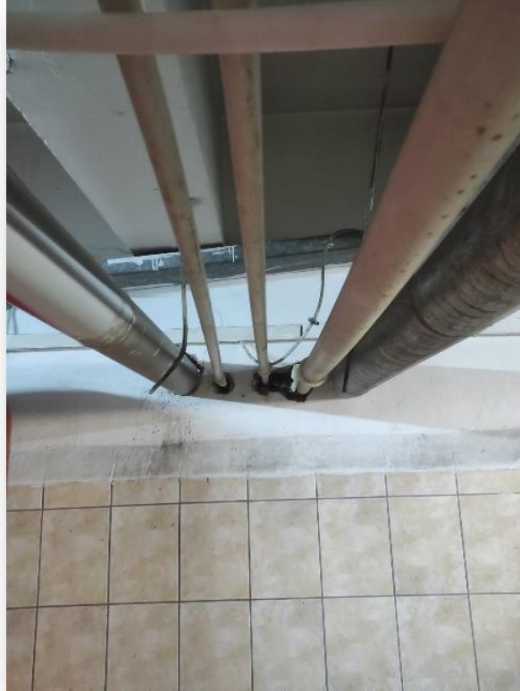
Görsel: Kampüs Altyapısı Proje Uygulamaları
