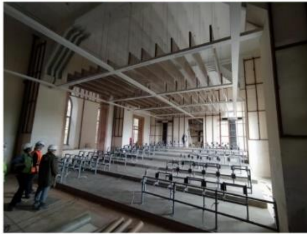
Görsel: Mektek-i Tıbbiye-i Şahane Binası II. Etap Restorasyonu Proje Uygulamaları
